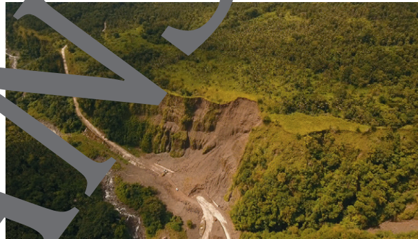
Erdrutsch an einer Straße
