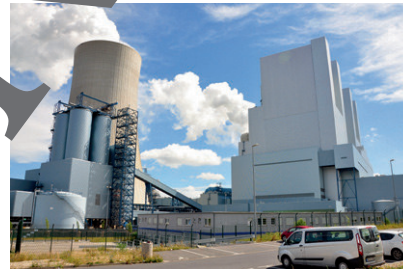
Braunkohlekraftwerk in Neurath
