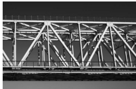
Abb. 2: Stabile Dreiecke werden bei Brücken genutzt.
