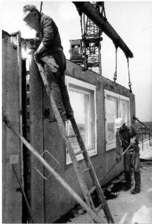
Ein Plattenbau wird errichtet
