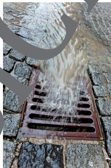
Abb.: Gully für die Straßenentwässerung
