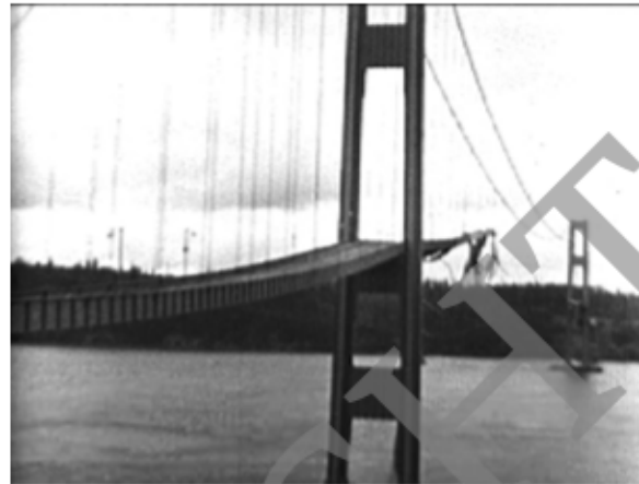
Die eingestürzte erste Tacoma-Narrows-Brücke
